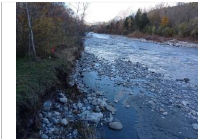
Vue générale du site. Photo © AGERIN 2023
