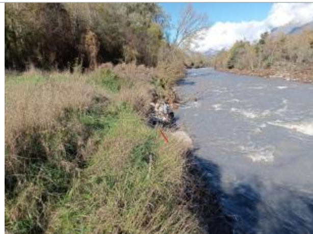
Vue générale du site. Photo © AGERIN 2023
