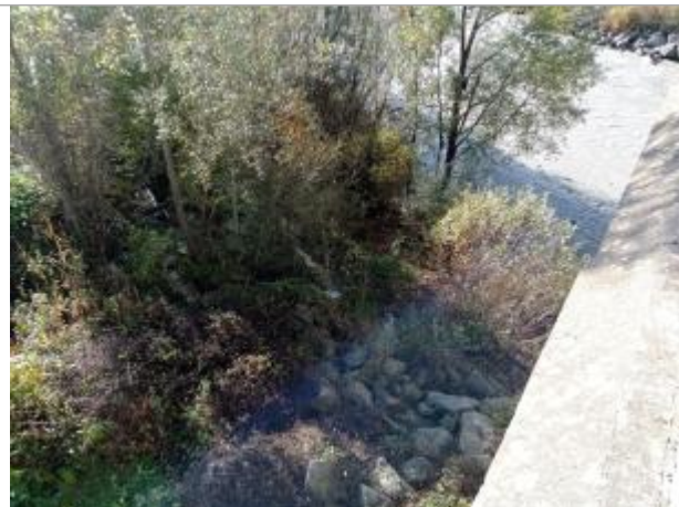
Vue générale du site. Photo © AGERIN 2023
