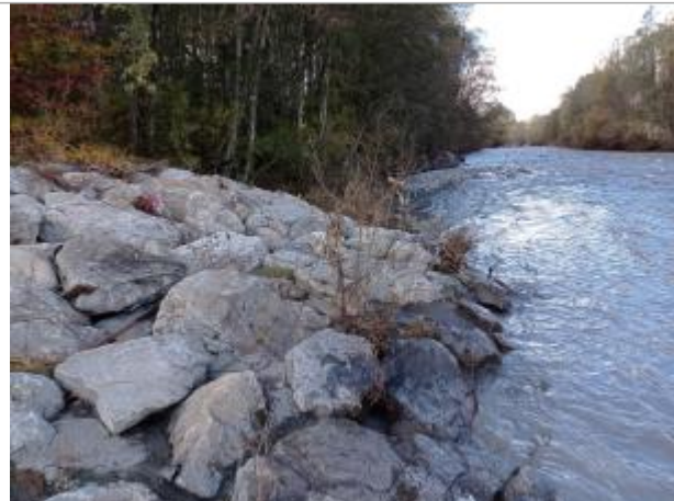
Vue générale du site. Photo © AGERIN 2023
