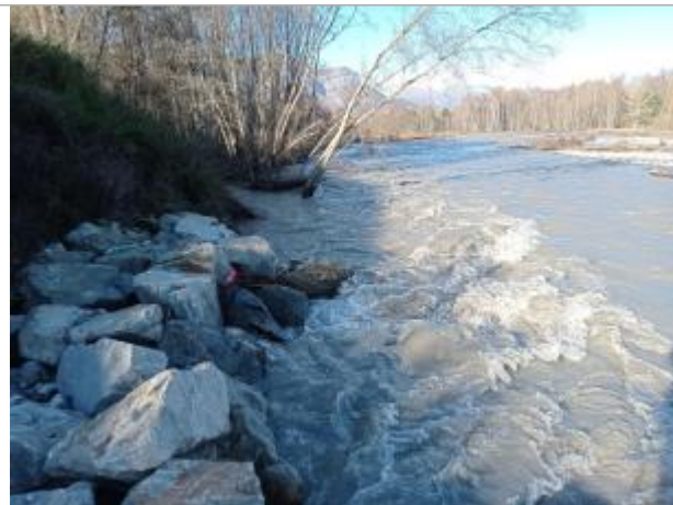
Vue générale du site. Photo © AGERIN 2023
