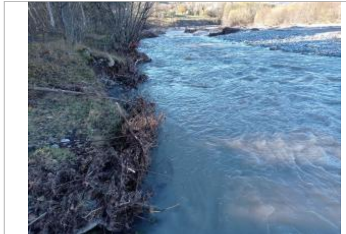
Vue générale du site. Photo © AGERIN 2023
