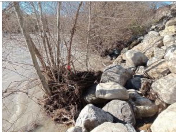
Vue générale du site. Photo © AGERIN 2023
