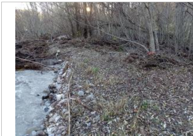
Vue générale du site. Photo © AGERIN 2023
