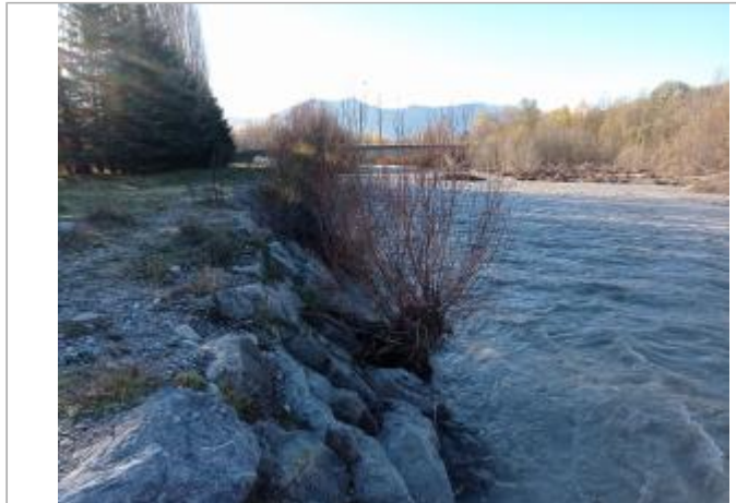
Vue générale du site. Photo © AGERIN 2023
