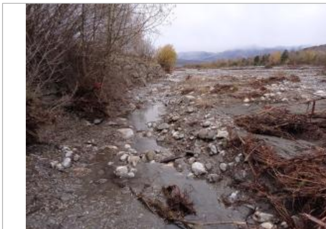
Vue générale du site. Photo © AGERIN 2023
