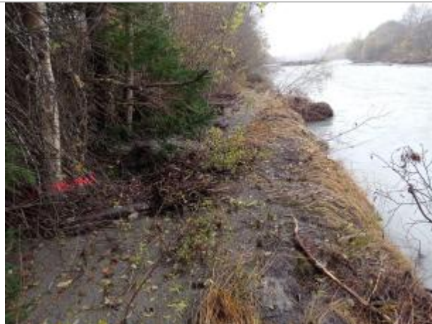
Vue générale du site. Photo © AGERIN 2023
