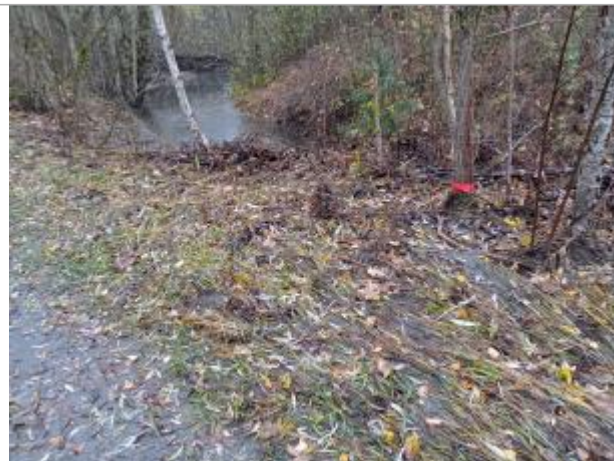
Vue générale du site. Photo © AGERIN 2023
