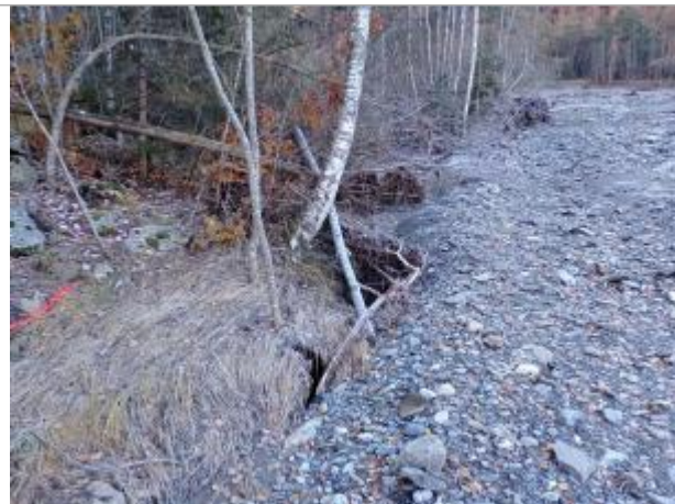
Vue générale du site. Photo © AGERIN 2023
