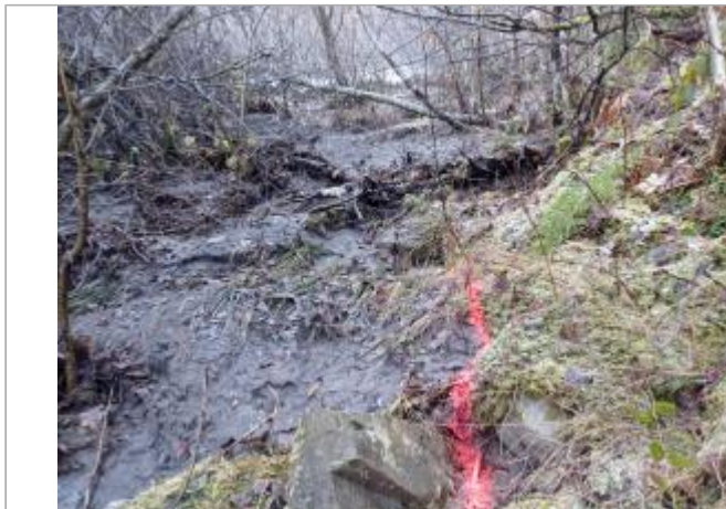
Vue générale du site. Photo © AGERIN 2023
