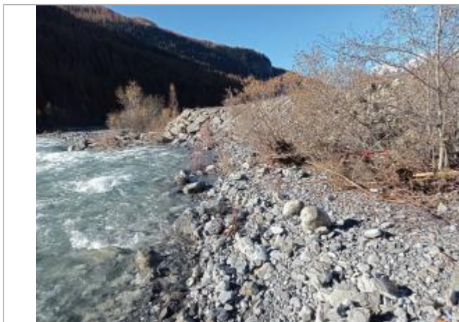
Vue générale du site. Photo © AGERIN 2023
