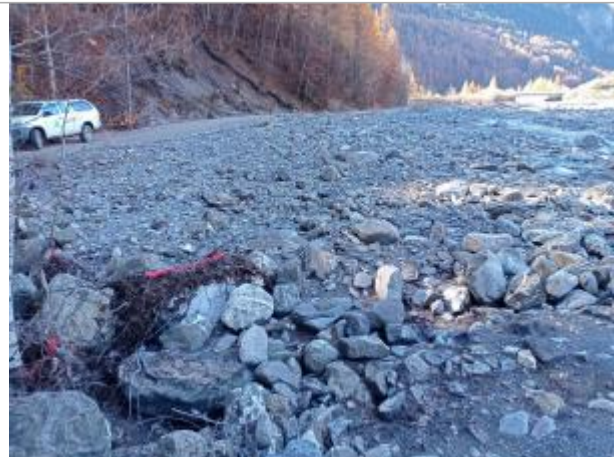
Vue générale du site. Photo © AGERIN 2023
