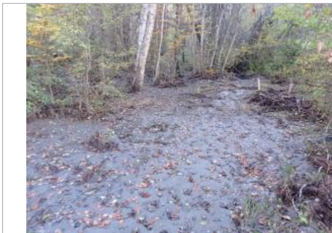
Vue générale du site. Photo © AGERIN 2023
