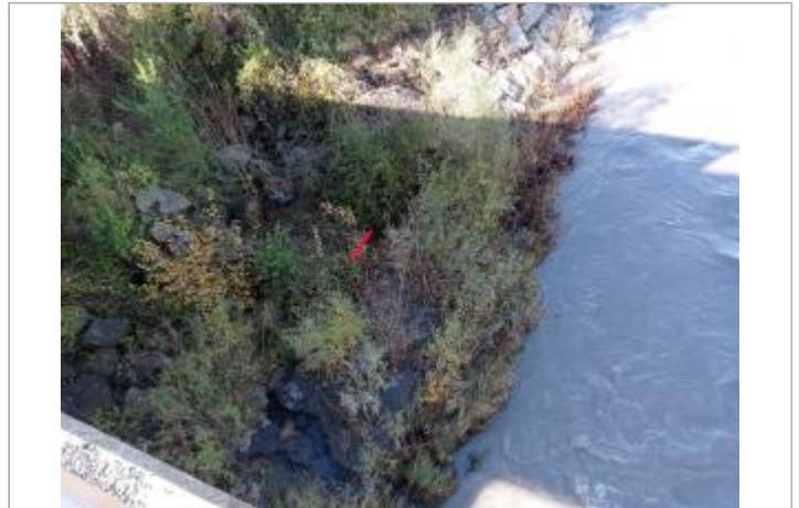
Vue générale du site. Photo © AGERIN 2023
