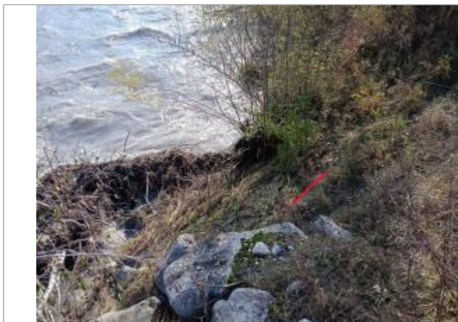
Vue générale du site. Photo © AGERIN 2023
