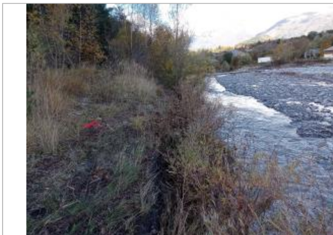
Vue générale du site. Photo © AGERIN 2023
