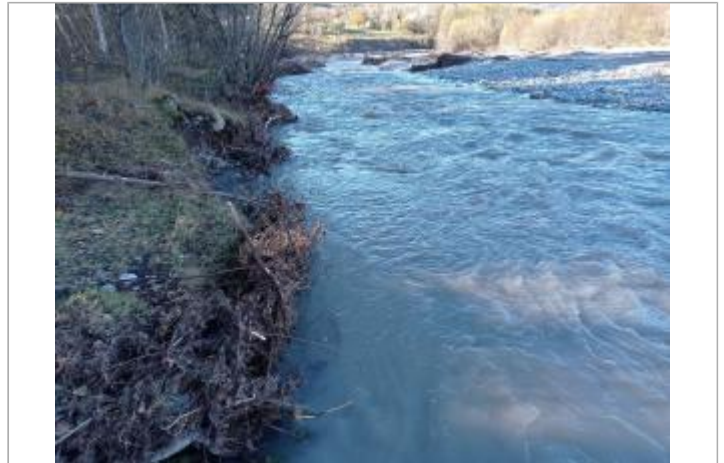
Vue générale du site. Photo © AGERIN 2023
