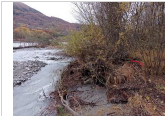
Vue générale du site. Photo © AGERIN 2023
