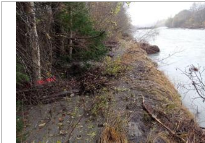
Vue générale du site. Photo © AGERIN 2023
