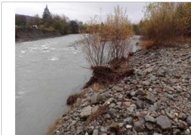
Vue générale du site. Photo © AGERIN 2023
