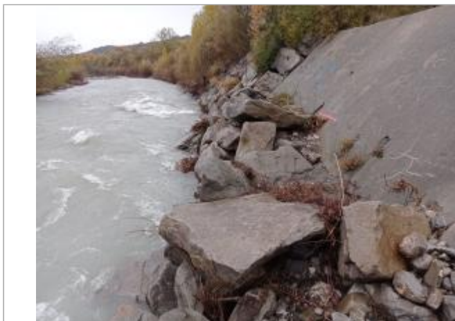
Vue générale du site. Photo © AGERIN 2023
