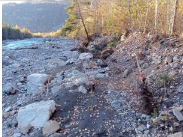
Vue générale du site. Photo © AGERIN 2023
