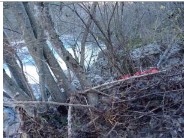
Vue générale du site. Photo © AGERIN 2023
