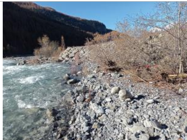
Vue générale du site. Photo © AGERIN 2023
