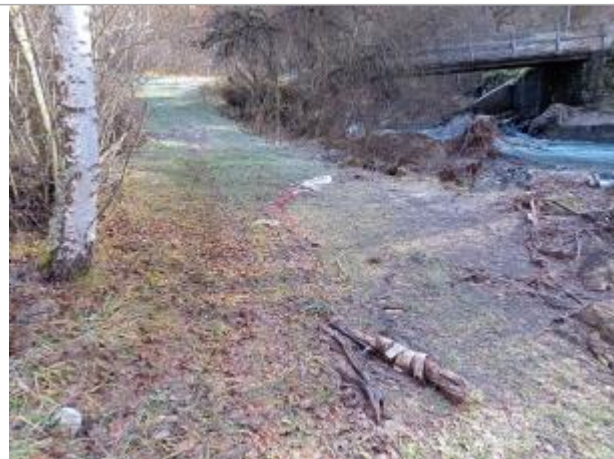
Vue générale du site. Photo © AGERIN 2023
