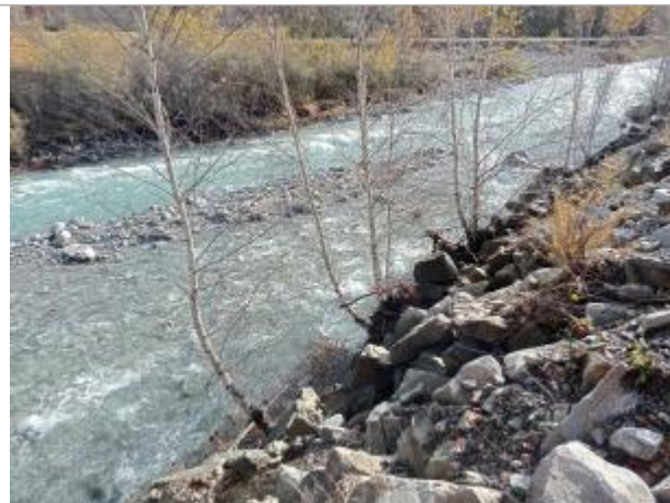
Vue générale du site. Photo © AGERIN 2023
