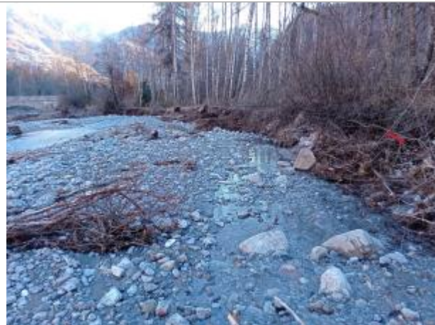
Vue générale du site. Photo © AGERIN 2023
