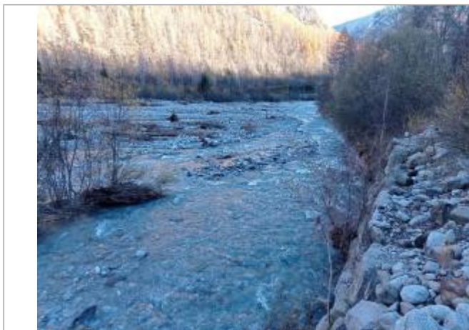
Vue générale du site. Photo © AGERIN 2023
