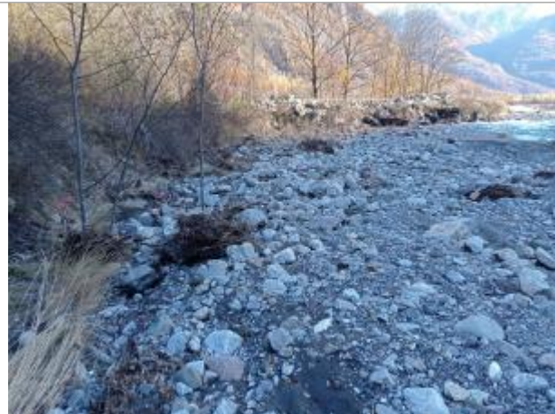
Vue générale du site. Photo © AGERIN 2023
