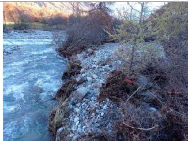
Vue générale du site. Photo © AGERIN 2023
