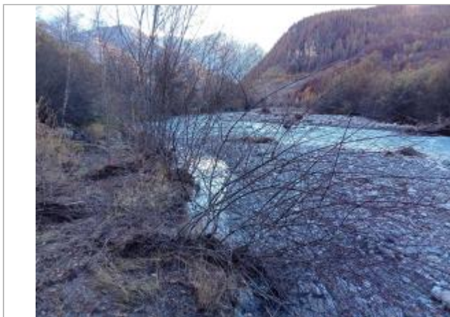
Vue générale du site. Photo © AGERIN 2023
