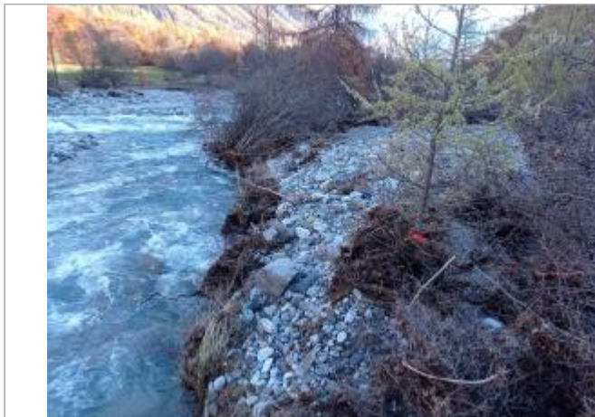
Vue générale du site. Photo © AGERIN 2023
