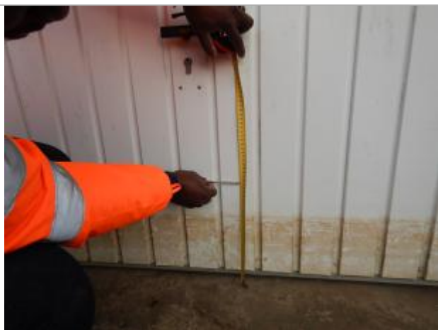
Le repère est au pieds d'une porte de garage.
