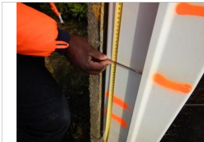
Le repère se trouve sur un coffret électrique
