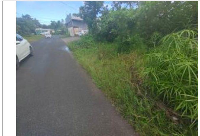
Dépôts de matières solides sur le bas côté de la route
