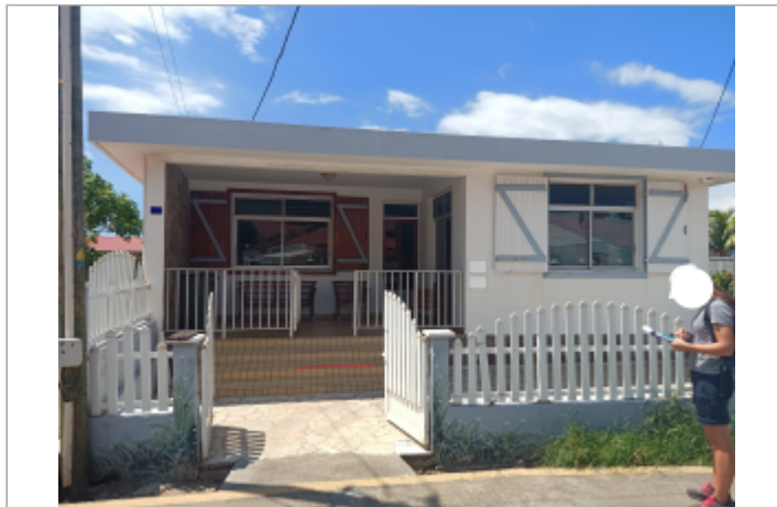
Hauteur d'eau arrivée à la deuxième marche
