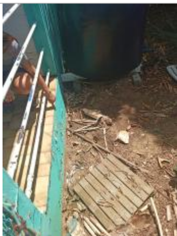
Témoignage de la hauteur d'eau
