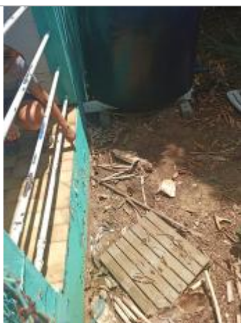
Témoignage de la hauteur d'eau
