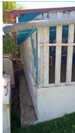
Façade extérieure le long du canal d'eaux pluviales
