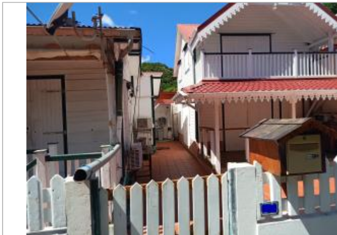
Couloir séparant les deux bâtiments
