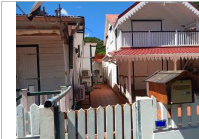
Couloir séparant les deux bâtiments
