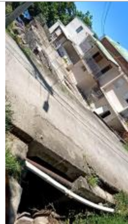
Vue depuis amont
