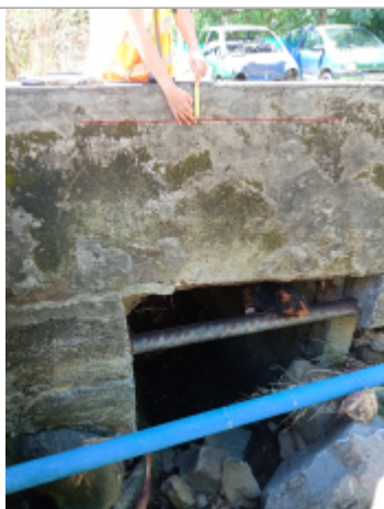
Parapet du pont, côté amont
