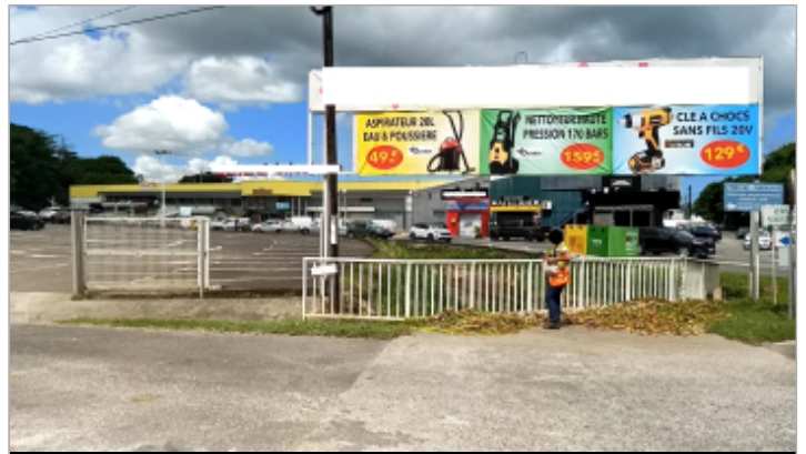
Laisse de crue sur un pont où les buses étaient bouchées
