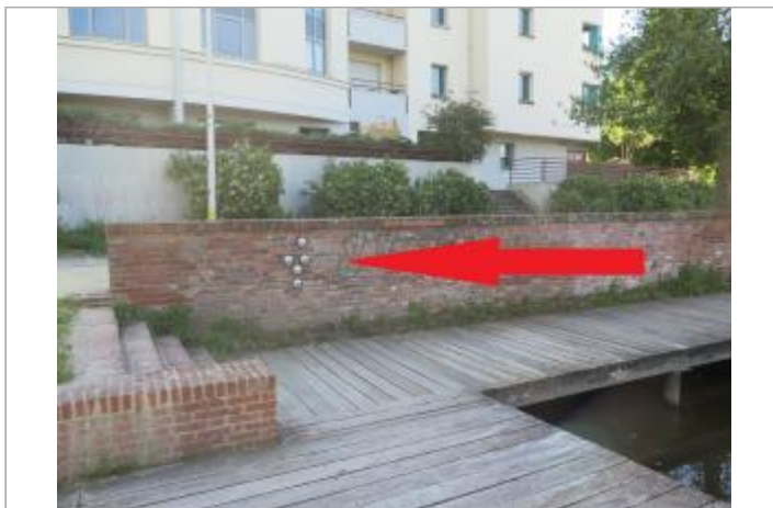
muret de brique
