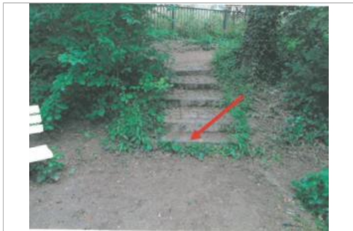
Escalier en aval de la rue de Brest, rive gauche
