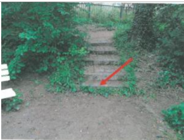
Escalier en aval de la rue de Brest, rive gauche
