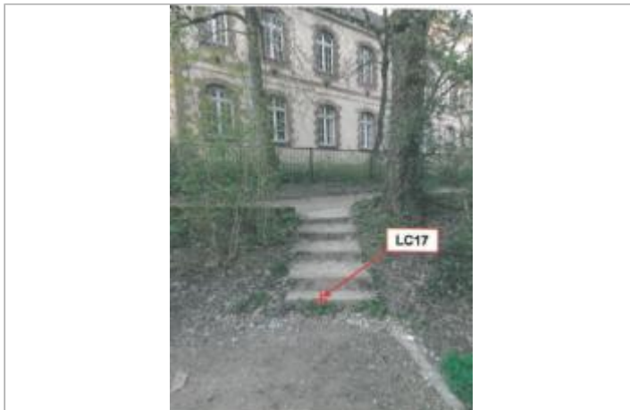
2ème escalier (le plus court) en aval de la rue Brest, rive gauche
