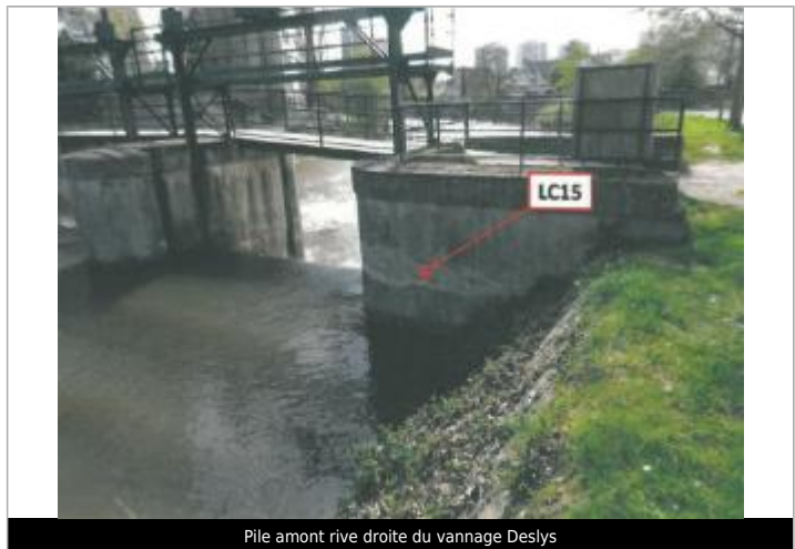
Pile amont rive droite du vannage Deslys
